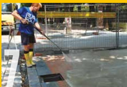
**6** La spruzzatura del disattivante deve essere realizzata immediatamente dopo la lisciatura, prima che il cemento abbia iniziato la presa, avendo cura che la sua applicazione avvenga in modo continuo, uniforme ed omogeneo per ottenere un risultato perfetto.
